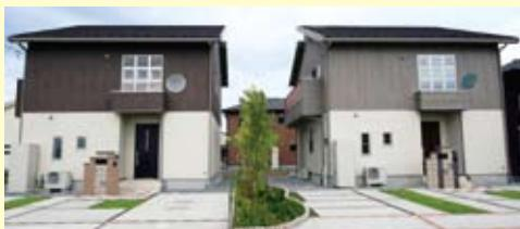
当社グループ分譲地「サイプレスガーデン加須」内に建築した実験棟において、2010年6月から住宅の気密・断熱性能の測定・検証実験を開始しました。ここでは、同じ間取りの「スマート・ワン」を隣り合わせに2棟建築し、一方には一般的な断熱材であるグラスウール、もう一方には当社グループで標準装備している高气密・高断熱の発泡断熱材「アクアフォーム」を使用しています。外気や室温・湿度と気密・断熱性能の関係や、エアコンの消費電力と気密・断熱性能の関係等を約1年かけて計測・検証していく予定です。この実験は分譲地内に実物大の実験施設を建築して検証を行っているため、より現実に即した結果が得られるものと大いに期待しています。
