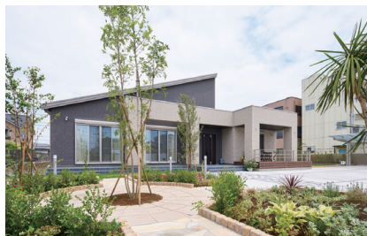
屋根・外壁リフォーム
