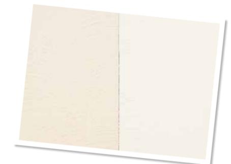
温度や湿度が変化することでできてしまう壁紙の隙間。コーキング剤を使えば、簡単に補修できます。継ぎ目の隙間だけでなく、壁紙が部分的に剥がれてしまった場合も同様に補修できます。
