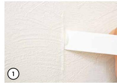
① ヘラを使い、壁紙の剥がれている部分に壁紙用のりを押し込みます。
