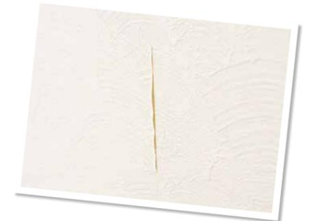
温度や湿度が変化することでできてしまう壁紙の隙間。壁紙用のりを使えば、簡単に補修できます。
