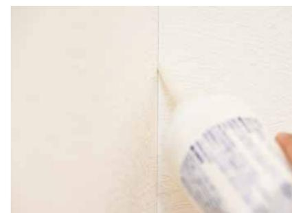
隙間に先端をあてがい、コーキング剤を少しずつ出しなが下に滑らせます。
