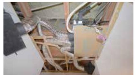
設備・木工事/天井内にエアコン室内機、各部屋へのダクト配管そして電気工事を行います。同時に機器設備のための補強など木工事を行います。
