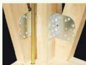
接合部の補強
