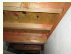
壁・基礎の補強
