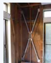
建物内に振動軽減装置を設置。地震のエネルギーを吸収します。
