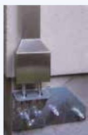
左／基礎・土台・柱を外から補強 右／内壁耐震ボード
