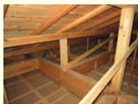
屋根・屋根裏・接合部
