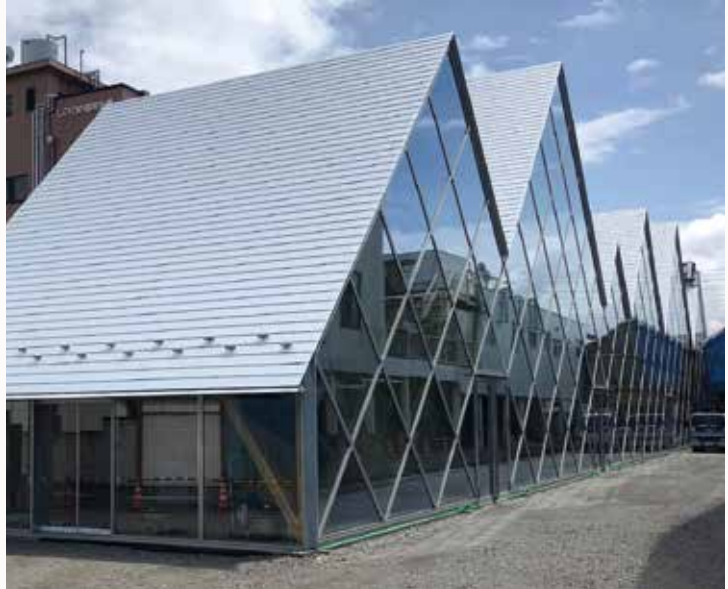
世界遺産の富岡製糸場と同じ「トラス構造」を取り入れ、大小の切り妻屋根が南北に細長く連なるデザインが特徴の富岡商工会議所新館。トラス構造は三角形の骨組みが特徴だ。 [写真提供:手塚建築研究所]
