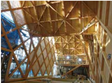
世界遺産の富岡製糸場と同じ「トラス構造」を取り入れ、大小の切り妻屋根が南北に細長く連なるデザインが特徴の富岡商工会議所新館。トラス構造は三角形の骨組みが特徴だ。 [写真提供:手塚建築研究所]
