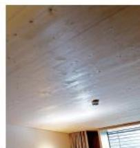
CLTの構造材がそのまま使われている天井、仕上げ材等は貼られていません。天井材と上階の床材はそれぞれ別なCLTを使用。その間に配管や配線の為の空間があり空間がある事で上階の音の問題も解消しています。
