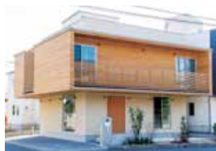
10月に竣工した2方1.82m跳ね出しのCLT伊奈モデルハウス
