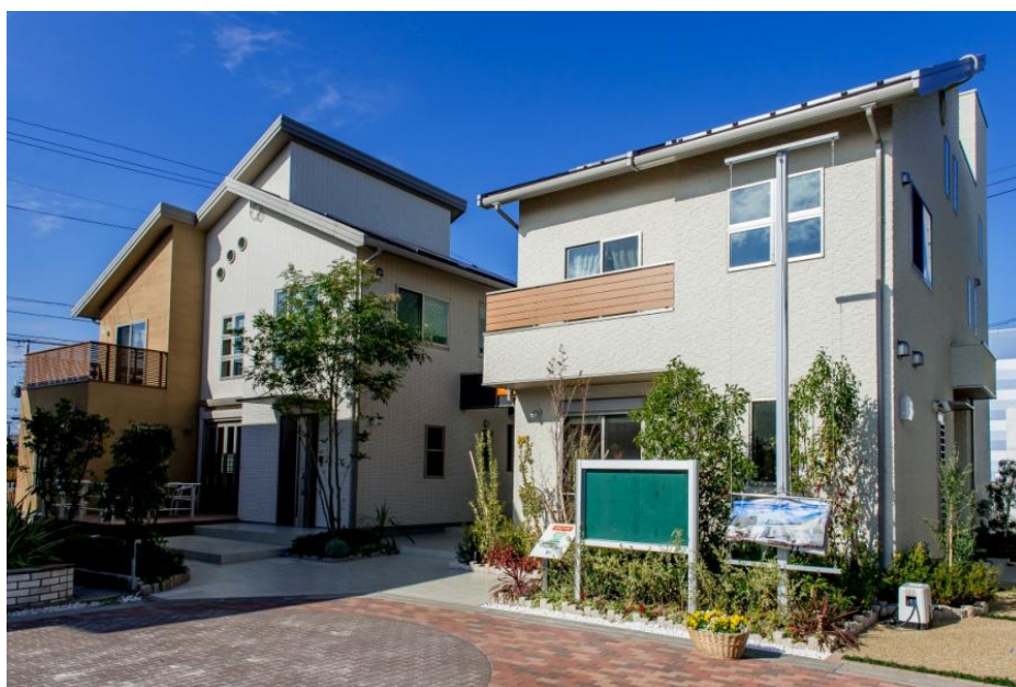
Z空調リフォームをしたスマート・ワン カスタム棟（左）
