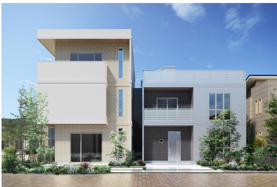
鉄筋コンクリート造の賃貸住宅棟（左）と自由設計戸建住宅「キューブフィット」棟（右）の両方を見られるレスコハウス 新川崎展示場。
